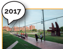
2017 Pèrgoles d'ombra al Parc de la Solidaritat. En procés de construcció.
